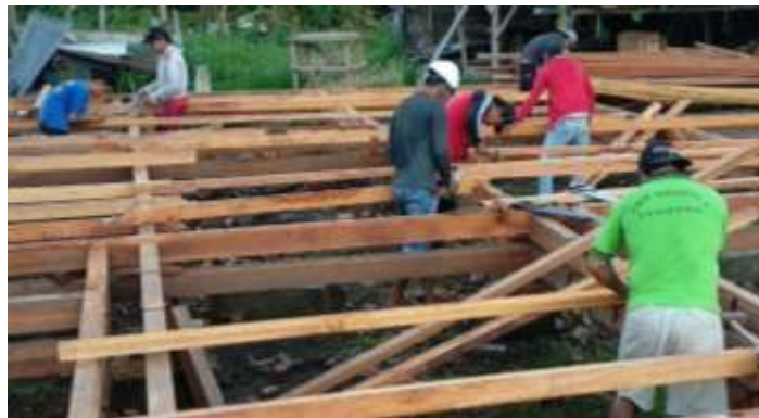
Gambar 5. Terlihat pekerja tidak menggunakan APD di area penyusunan struktur Rumah kayu
