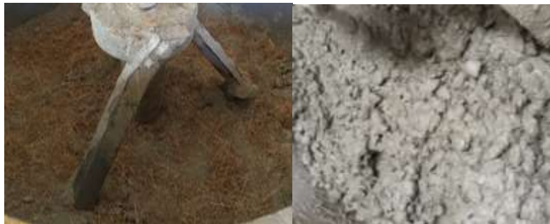
Gambar 2. Pencampuran serat abaca ke dalam concrete mixer
