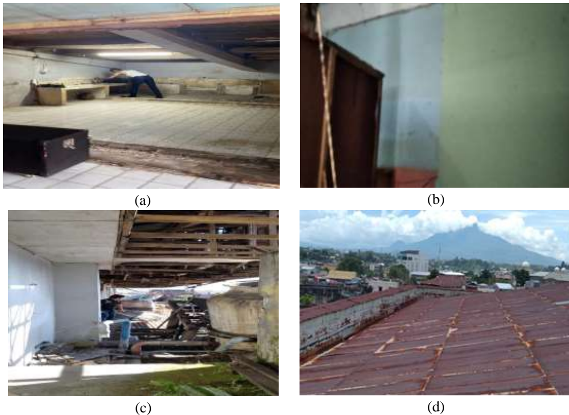
Gambar 4. Kerusakan bangunan lantai 4 bagian (a) Lantai, (b) dinding, (c) langit-langit, (d) atap
