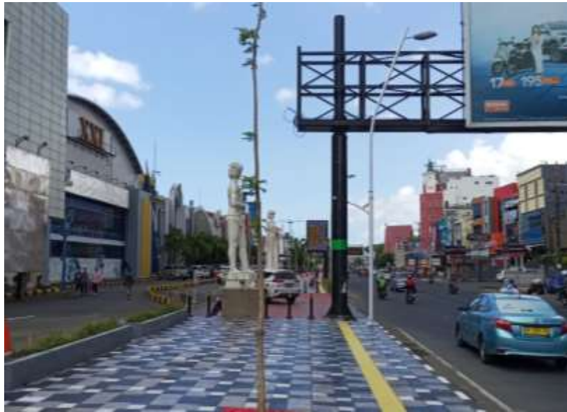
Gambar 2. Letak portal pencegah masuknya kendaraan roda dua dan tiang papan iklan yang menghalangi guiding block
