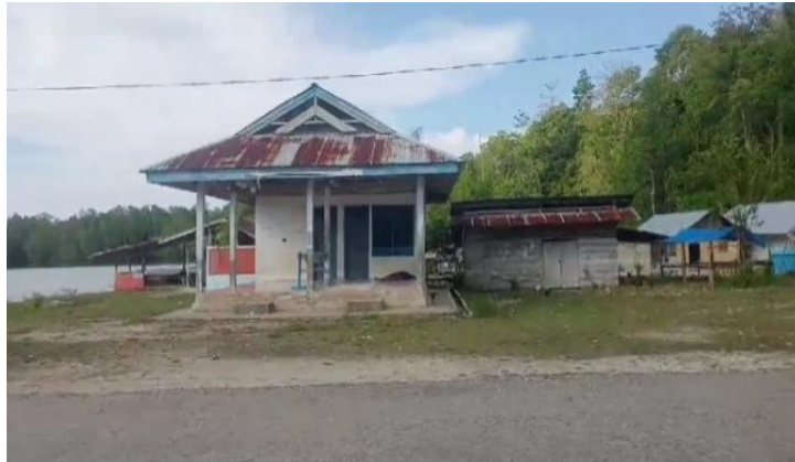
Gambar 2. Kondisi Eksisting Terminal Penumpang
