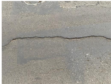
Gambar 6. Retak Memanjang/Melintang
