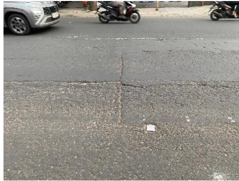
Gambar 5. Retak Sudut
