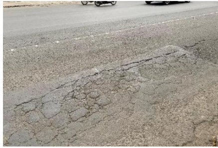
Gambar 2. Retak Kulit Buaya
