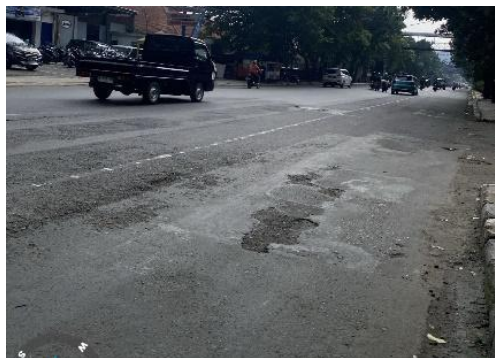
Gambar 8. Pengelupasan Lapis Permukaan
