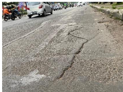
Gambar 3. Retak Pinggir
