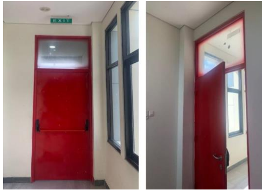
Gambar 5. Pintu Darurat dan tanda exit di GKT Polimdo
