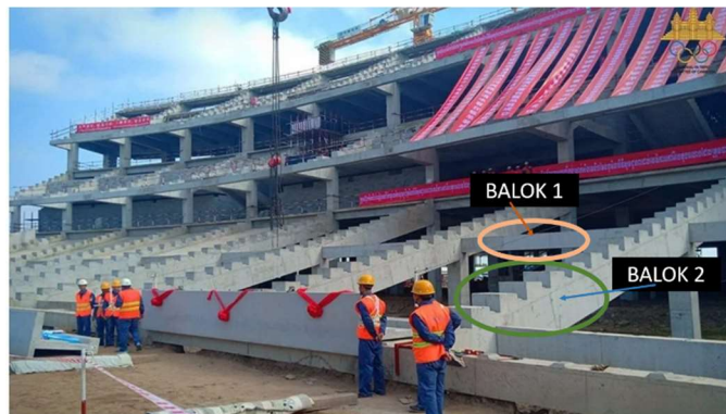
Gambar 3. Gambaran Komponen Struktur Balok 1, Balok 2
