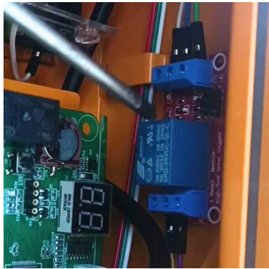
Gambar 7. Gambar Pemasangan Relay
