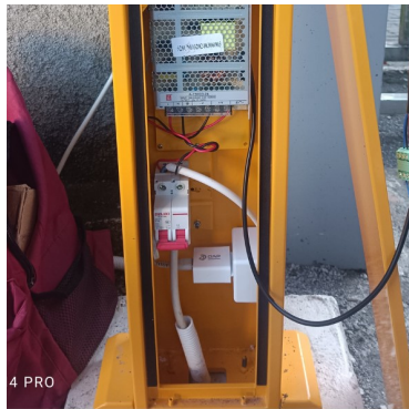
Gambar 8. Pemasangan Adaptor 5V
