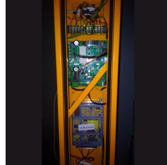
Gambar 10. Pemasangan kontrol palang
