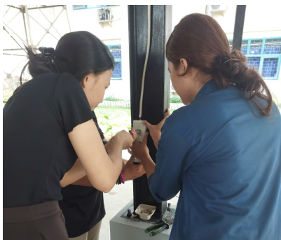
4. Pemasangan Stop Kontak
