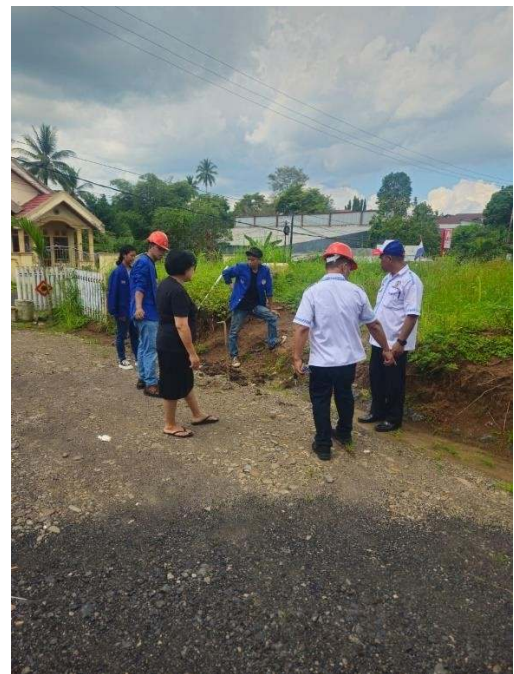
Gambar 5 Pengarahan dari Ketua Jemaat untuk menentukan posisi instalasi listrik
