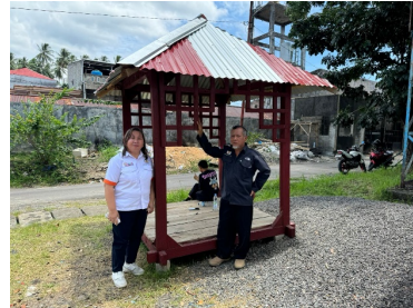
Gambar 9. Konstruksi Gazebo yang dibuat di Bengkel Kayu
