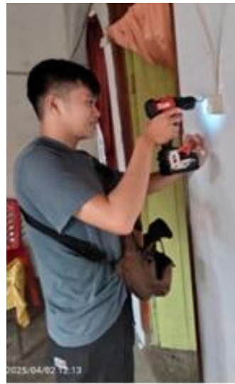
Gambar 6. Memasang saklar lampu
