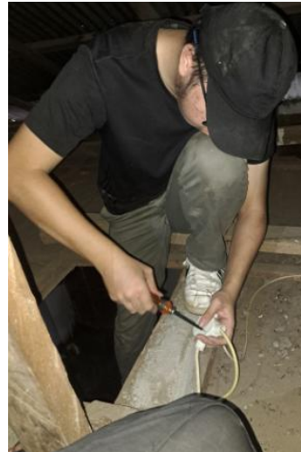
Gambar 7. Sambungan kabel pada T Dos
