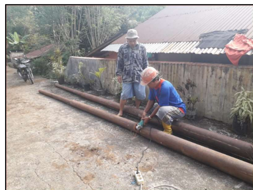
Gambar 3. Masyarakat menyiapkan tiang untuk dipasangkan lampu jalan
