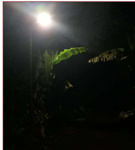
Gambar 6. Penerangan lampu jalan berfungsi menerangi jalan pada malam hari
