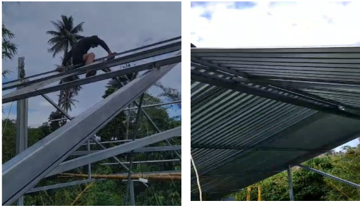
Hasil pembuatan atap dengan konstruksi baja
