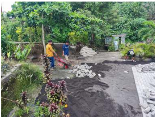
Gambar 4. Pelaksanaan Pekerjaan Pemasangan Paving blok
