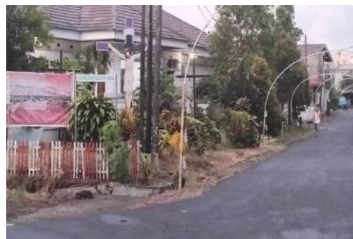
Gambar 2. Akses jalan masuk ke Perumahan Politeknik Indah
