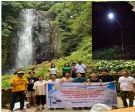
Gambar 7. Pemasangan Tiang pipa Lampu Jalan Tenaga Surya Pos3
