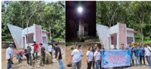
Gambar 3. Pemasangan Tiang pipa Lampu Jalan Tenaga Surya Pos1
