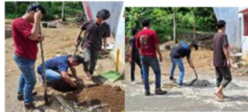
Gambar 2. Penggalian tanah dan pencampuran semen untuk Pipa lampu jalan Tenaga Surya
