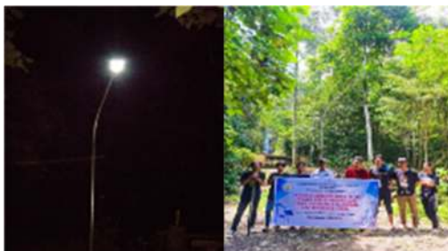
Gambar 5. Pemasangan Tiang pipa Lampu Jalan Tenaga Surya Pos2
