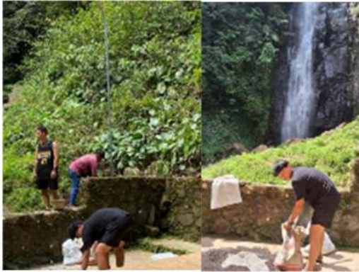
Gambar 6. Proses pemasangan Tiang pipa Lampu Jalan Tenaga Surya Pos3
