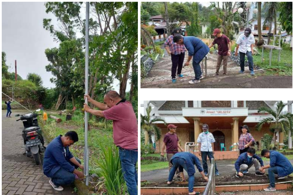
Gambar 4. Proses Perbaikan Instalasi Listrik Penerangan Lampu Jalan dan Lampu Taman
