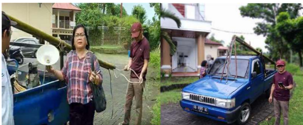
Gambar 2. Tiang lampu jalan di lepas untuk di cat kembali dan diganti jalur kabel instalasi yang baru (lokasi Gereja GMIM Malendeng)
