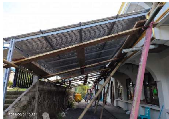
Gambar 2. Tahapan pemasangan baja ringan
