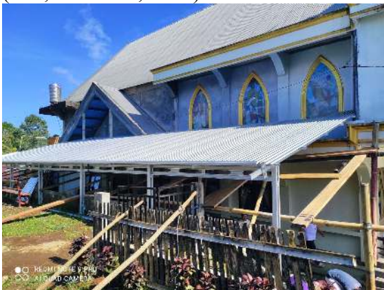
Gambar 3. Hasil implementasi baja ringan untuk teras GMIM NVC
