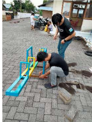
Gambar 5.a. Pemasangan APE “Jungkat - Jangkit”
