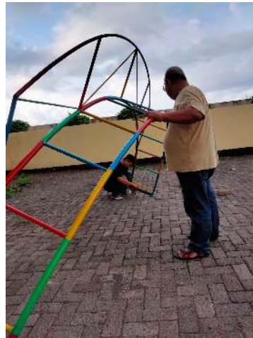
Gambar 5.b. Pemasangan APE “Tangga Lengkung”.
