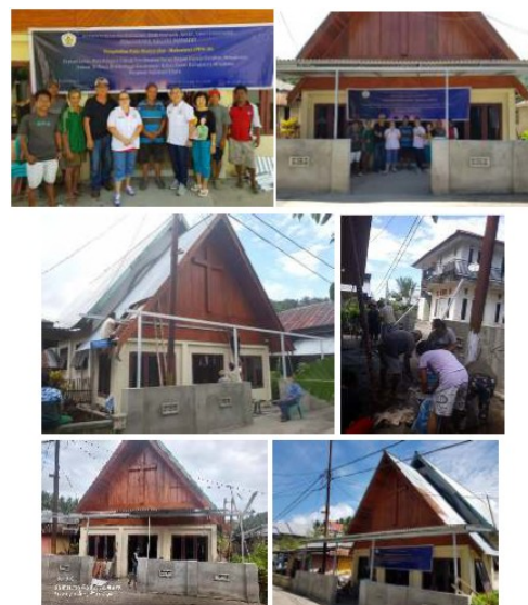
Gambar 4. Pelaksanaan pembuatan teras di depan bangunan gereja
