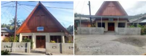
Gambar 5. Tampak depan bangunan gereja sebelum dan sesudah pembangunan teras
