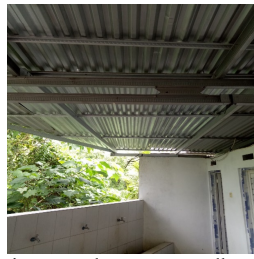
Hasil pemasangan atap baja ringan pada tempat wudhu Masjid.
