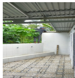
Pembuatan atap menggunakan baja ringan pada tempat wudhu masjid
