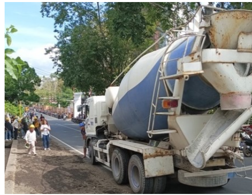
Gambar 8. Ready Mix Concrete dan pasir dasar
