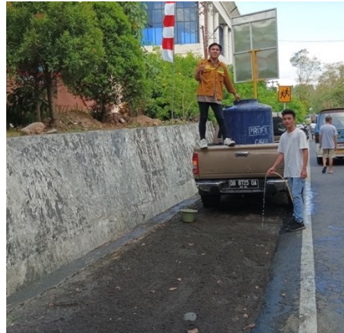
Gambar 14. Pemadatan dan penyiraman air
