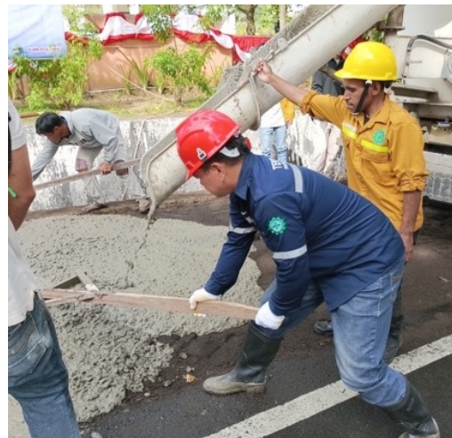
Gambar 15. Penyebaran material beton
