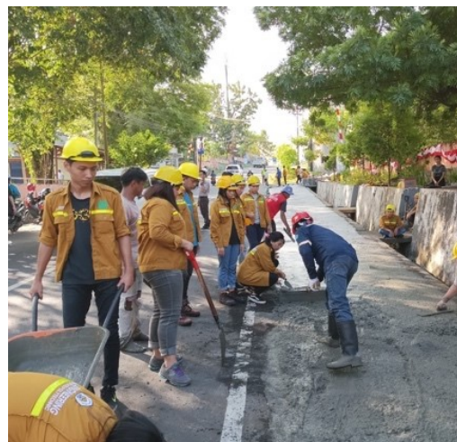
Gambar 15. Penyebaran material beton
