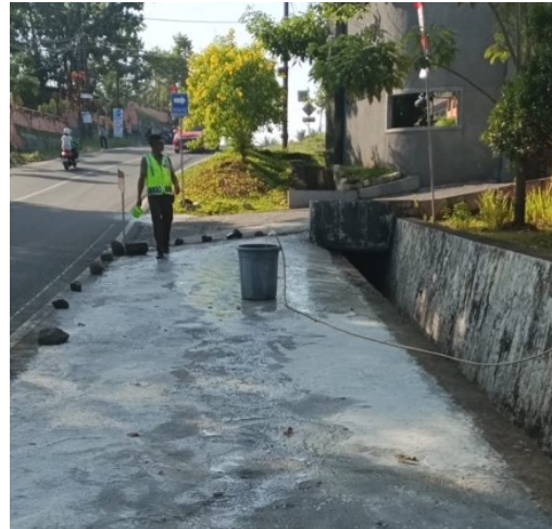
Gambar 20. Pemeliharaan beton
