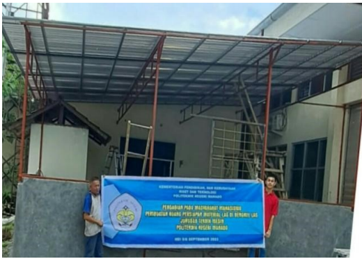
Gambar 3. Bangunan Selesai di bangun
