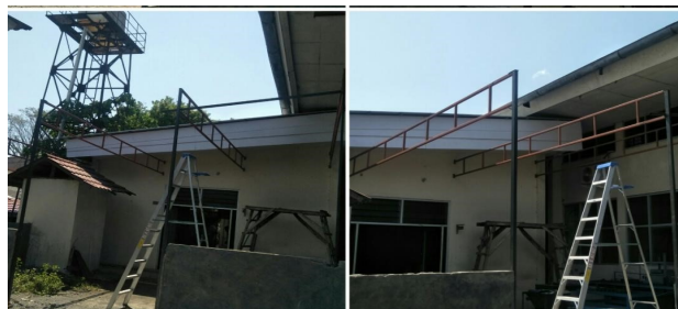
Gambar 2 Tahapan pemasangan . Rangka Tiang bangunan
