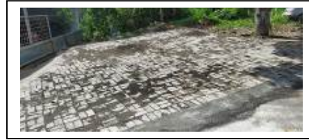
Gambar hasil pembuatan/pemasangan paving block.
