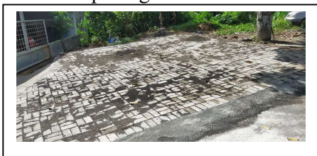
Gambar Proses pembuatan/pemasangan paving block
