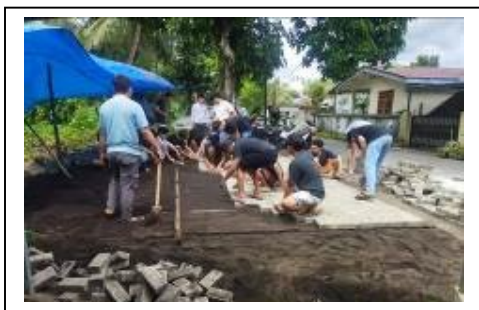
Gambar Proses pembuatan/pemasangan paving block
