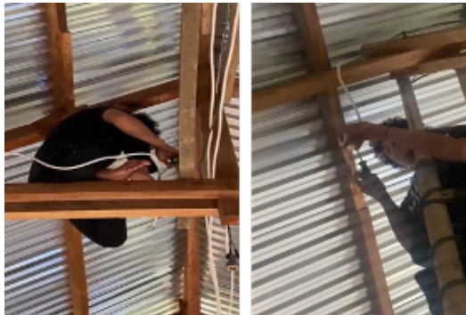
Gambar 8. Pemasangan Fitting Lampu
