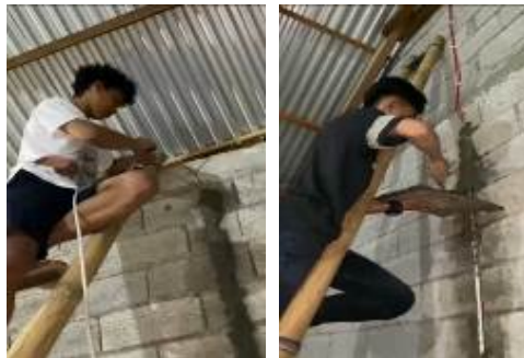
Gambar 6. Pemasangan Pipa dan Kabel Listrik
