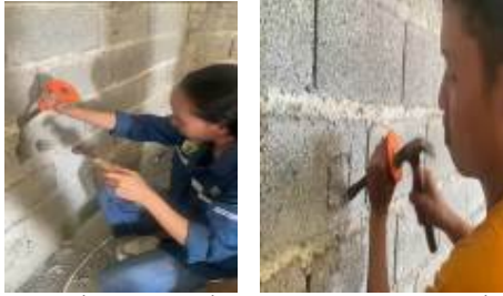
Gambar 5. Membuat Tempat Stop Kontak
