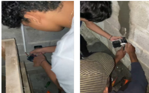
Gambar 7. Pemasangan Stop Kontak
