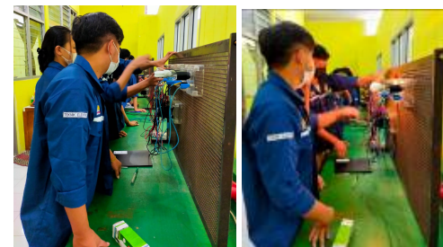
Gambar 3. Pelatihan Instalasi Penerangan
