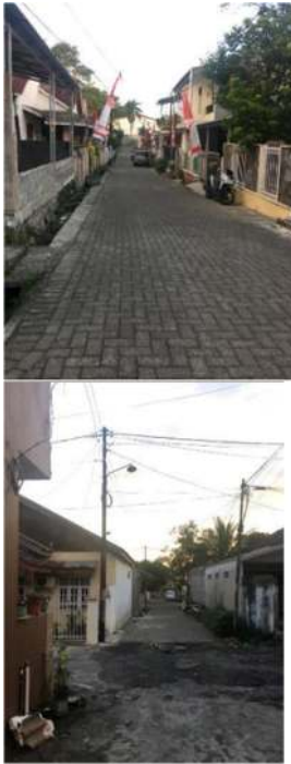
Gambar 3. Infrastruktur jalan dalam Perumahan Politeknik Indah
