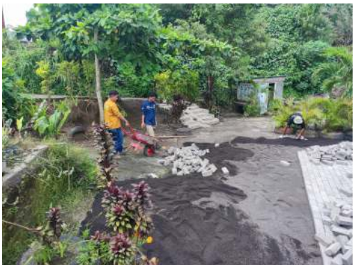
Gambar 4. Pelaksanaan Pekerjaan Pemasangan Paving blok
